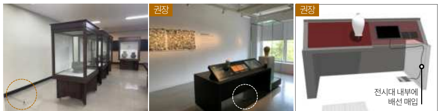
지양: 배선과 콘센트 노출 권장: 바닥 매입형 콘센트 설치 권장: 전시대 내부에 배선 매입 구조
