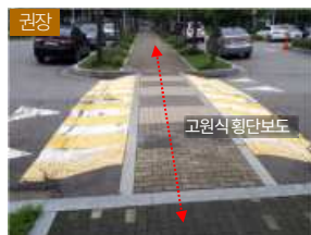
단절된 보도를 연결하는 고원식 횡단보도 설치
