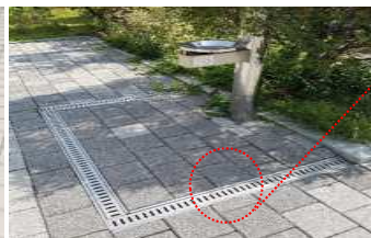
실외휴게공간 내 음수대 주변 그레이팅 설치 예시
