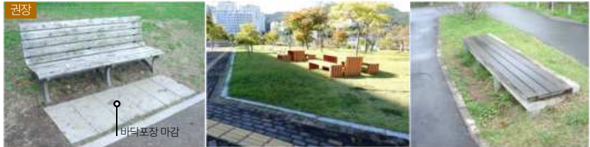
권장: 휴게의자 하부 바닥 포장 적용 지양: 비포장 바닥 및 단차로 인해 휠체어 이용자의 접근 및 이용 제한
