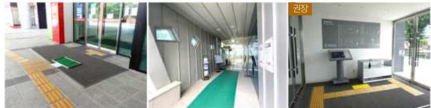
지양: 점자블록 위 이동형 발매트 설치 지양: 고채도 원색의 발매트 설치 권장: 매입형 발매트 설치
