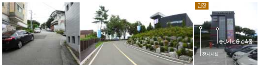
접근도로의 경사가 급해 법적 기울기를 충족하는 보행자 접근로의 조성이 불가능한 경우 승강기 전용 건축물
