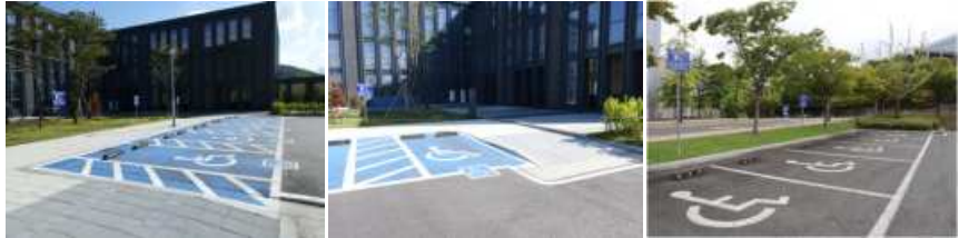
지양: 장애인전용주차구역에서 단차없이 보도로 접근할 수 있으나 점자블록 미설치 지양: 주차구역과 보도 사이의 단차 발생
