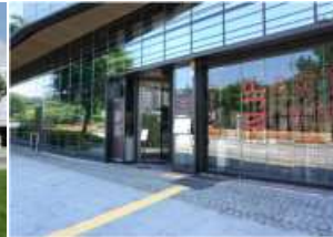
점자블록 위에 발매트 또는 고무매트를 설치하여 시각장애인의 동선 안내 불가
