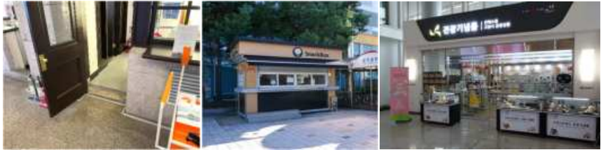
휠체어 이용자 및 시각장애인 등 일부 이용자의 접근과 이용이 어려운 카운터 및 출입구
