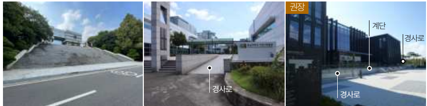
지양: 계단만 설치한 출입구 지양: 경사로는 있으나 안전바 미설치 권장: 양방향의 경사로는 계단 설치
