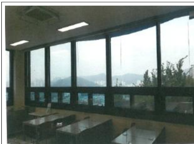
제2인문관 외벽 창호 개선공사
