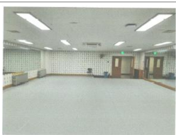
제1예술관 전공실 바닥 개선 공사
