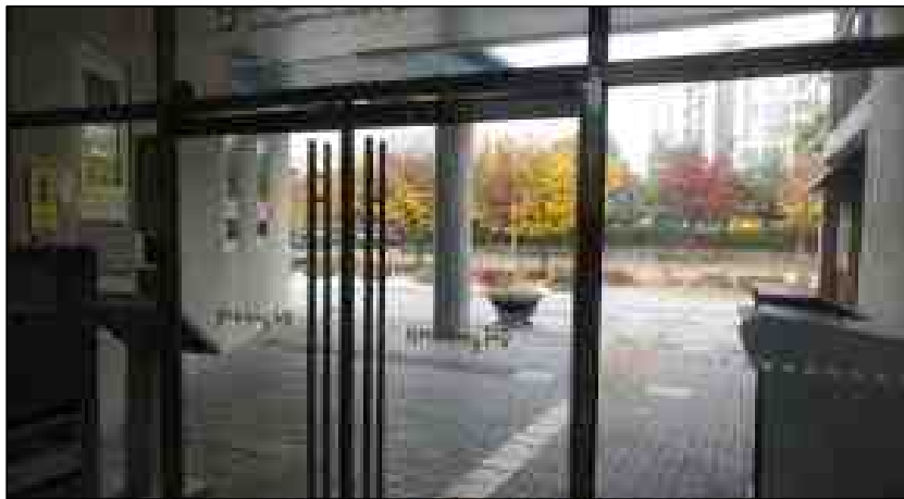
【개선 전 - 여닫이 출입문】
