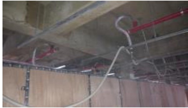
내진(구조)보강 공사 추진 중
