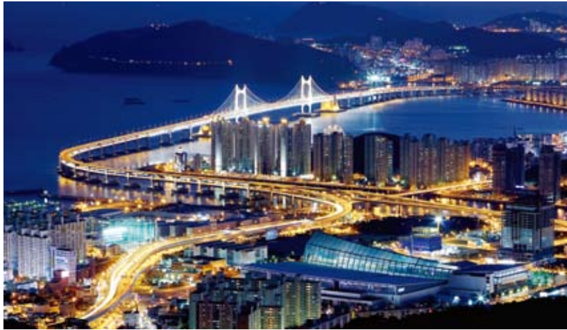
広安(クワンアン)大橋は、釜山市海雲台(ヘウンデ)区にある吊り橋です。総延長7420m。韓国で初めての二層構造の吊り橋です。
