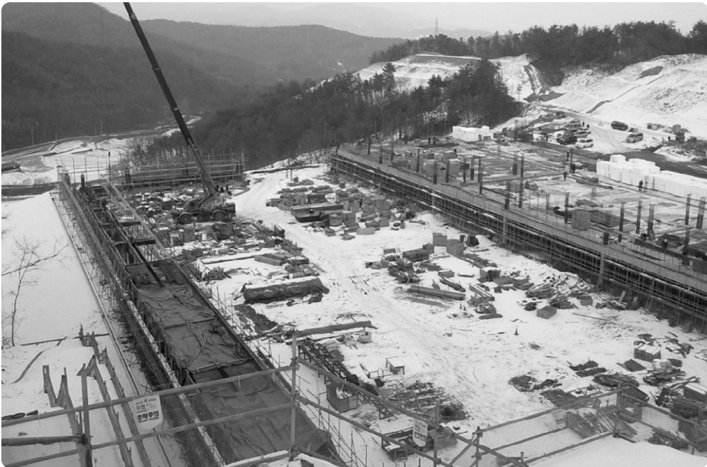
| 그림 6-3 | 실내사격장 2층 골조 공사(2010년 12월 현재)
