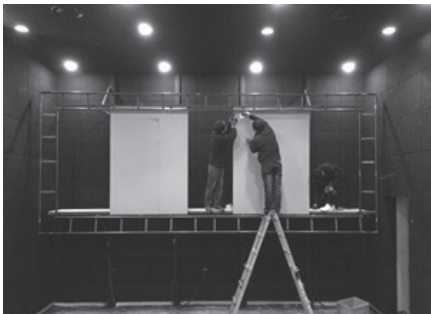
배플 석고보드 시공
