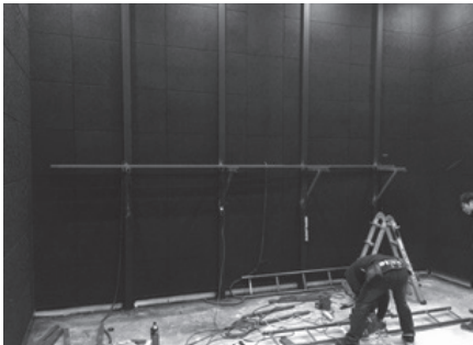
스크린 프레임 설치
