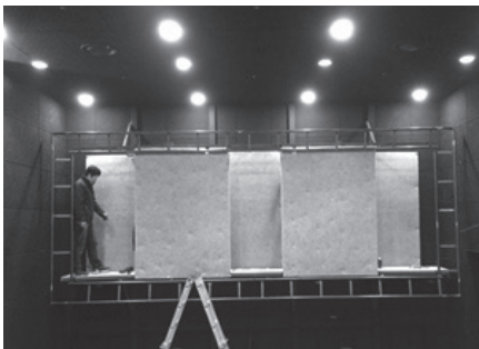
배플 그라스울 시공
