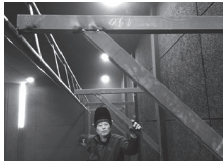
스크린 프레임 뒷벽 지지대 설치
