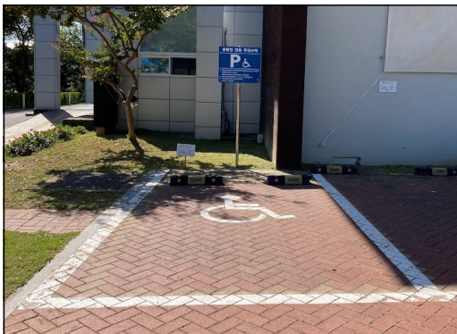
[그림 IV-9] 기준에 맞지 않는 바닥마감 및 안내표시
