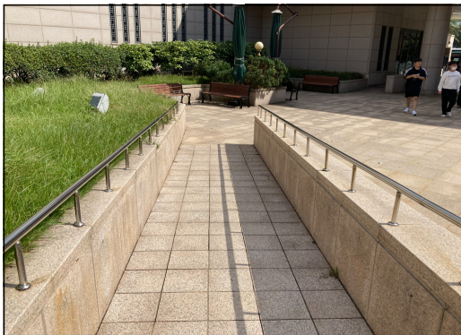
[그림 IV-13] 경사로 기울기 및 손잡이 설치
