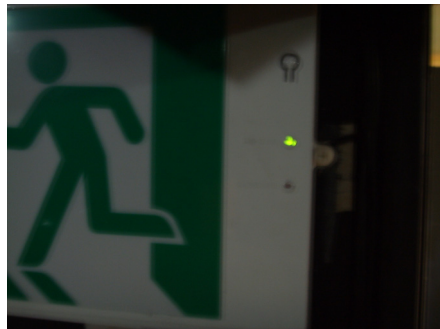
Ⅰ 그림 105 피난구 유도등 점검스위치 및 전원감시등 Ⅰ
