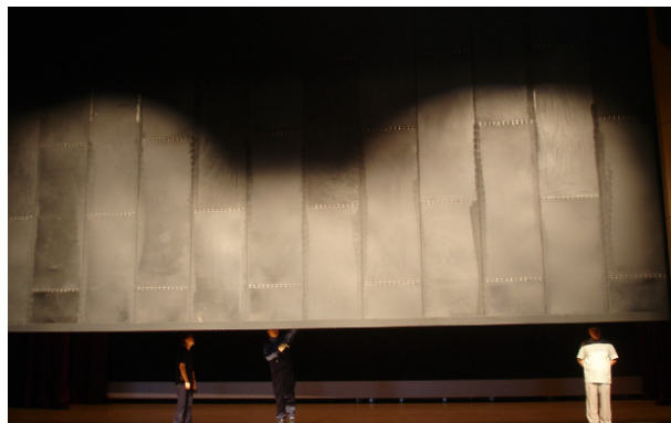
Ⅵ 그림 110 방화막 설치 예 Ⅵ
